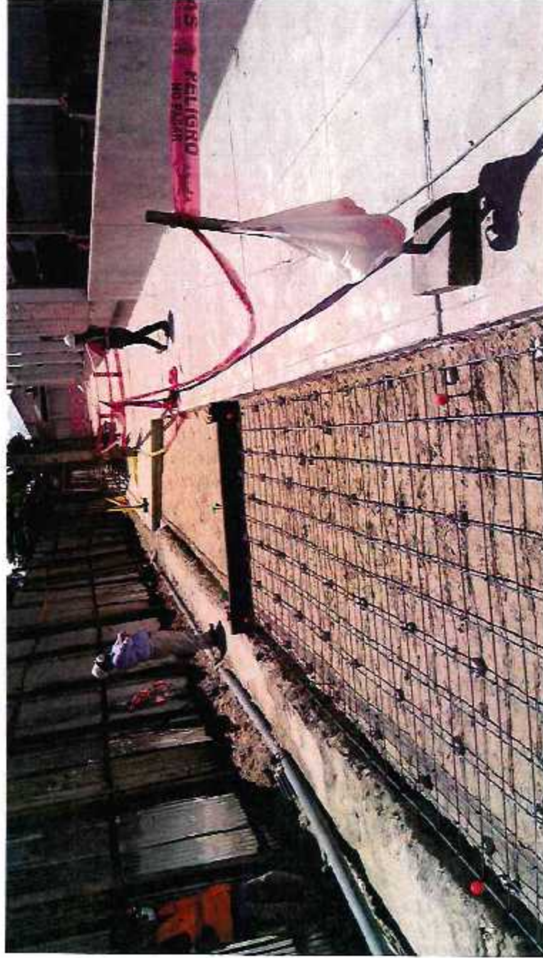
Encofrado, armado y vaciado de Veredas, Pavimentos y Rampas
